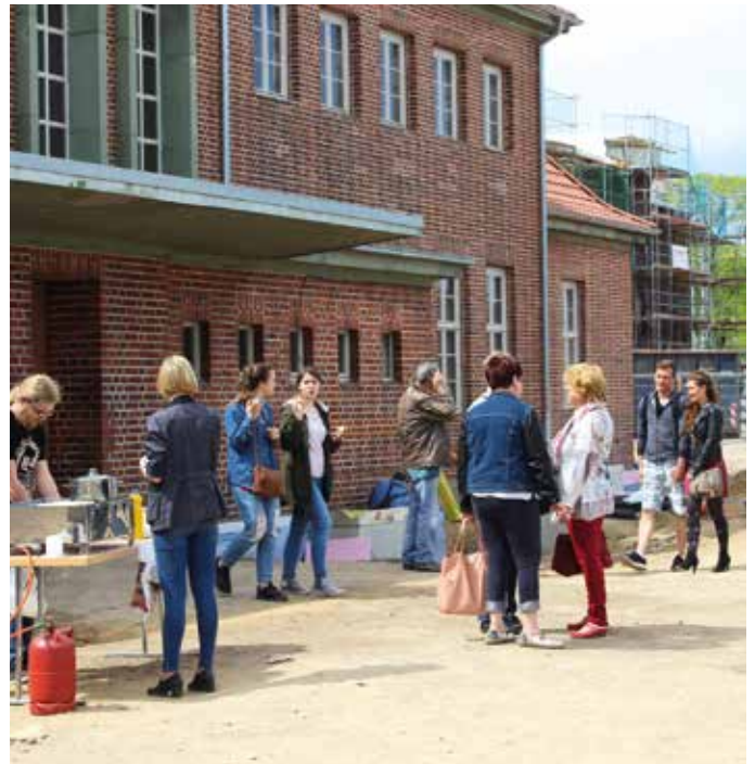
Die Besucher informierten sich im Innen- und Außenbereich des Bahnhofsareals über den Stand der Sanierungsarbeiten.
