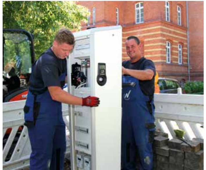
Im Juli 2018 haben die Netzmonteure Dennis Schier (l.) und Thomas Mackut der Stadtwerke Neuruppin die E-Ladesäule vor dem Rathaus der Stadt installiert.
